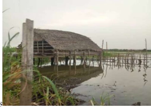
Photo 6 : Habitat sur piloti
