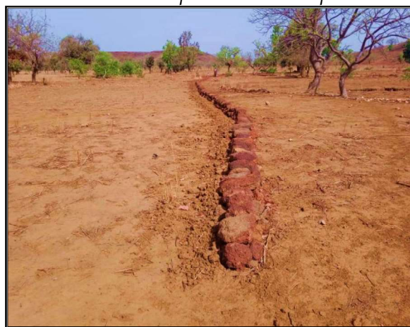
Photo 1: Mise en place de cordons pierreux
