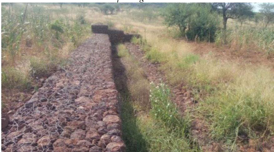
Photo 1 : Seuil d'épandage construit à Karkara.
