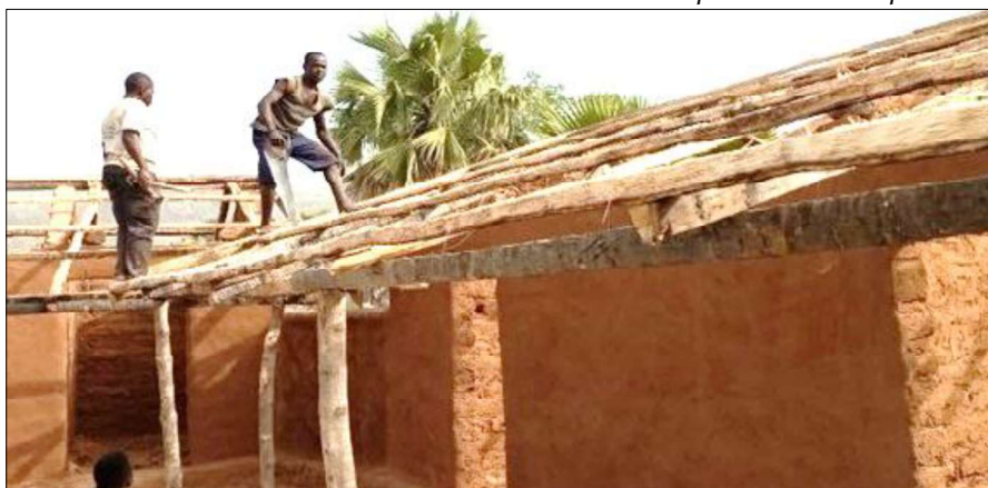
Photo 1 : Case en couvaison avec des cockers du stipe comme charpente
