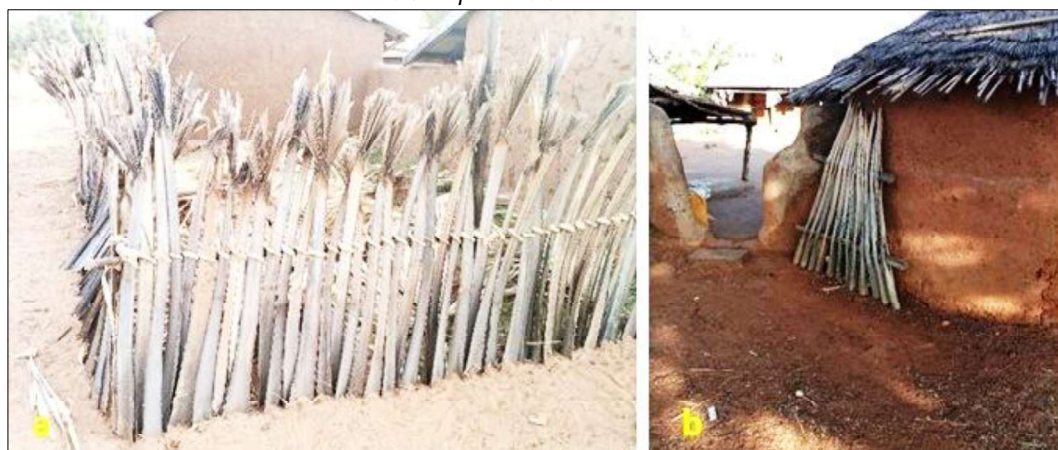
Photo 2 : Clôture (a) et porte (b) à base de ramures de rônier
