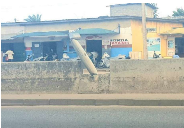
Lampadaire solaire détruit
