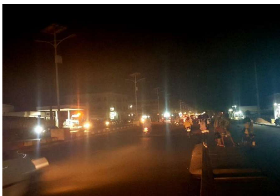
Absence d'éclairage sur la RNIE 2
