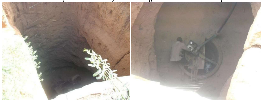
Planche des photos 2 : Plates-formes d'irrigation à l'intérieur d'un puits
