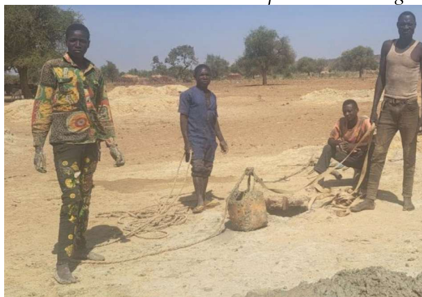
Photo 5 : Désensablement d'un puisard à kouréga
