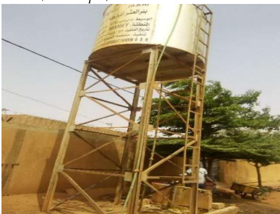
Photo 3 : Forage muni d'un château d'eau en acier (métallique)
