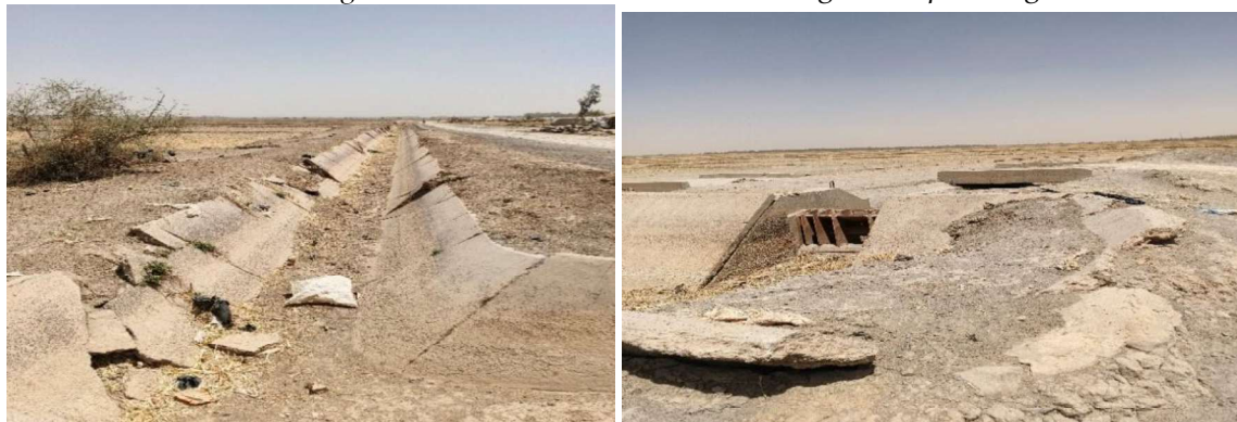
Photo 3 : Canal d'irrigation d'Hamadia Photo 4 : Ouvrage de dispatching à Hamadia
